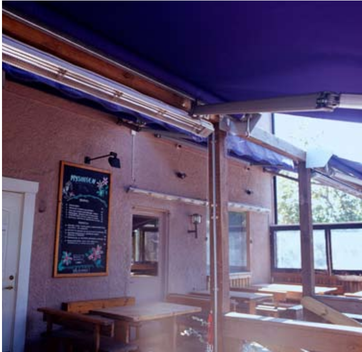
CIR-Strahler sind die ideale Komfort-Lösung für den Außenbereich von Restaurants. Die Heizungen können an der Wand des Restaurants oder in Reihe direkt über den Tischen großer Terrassen installiert werden.
